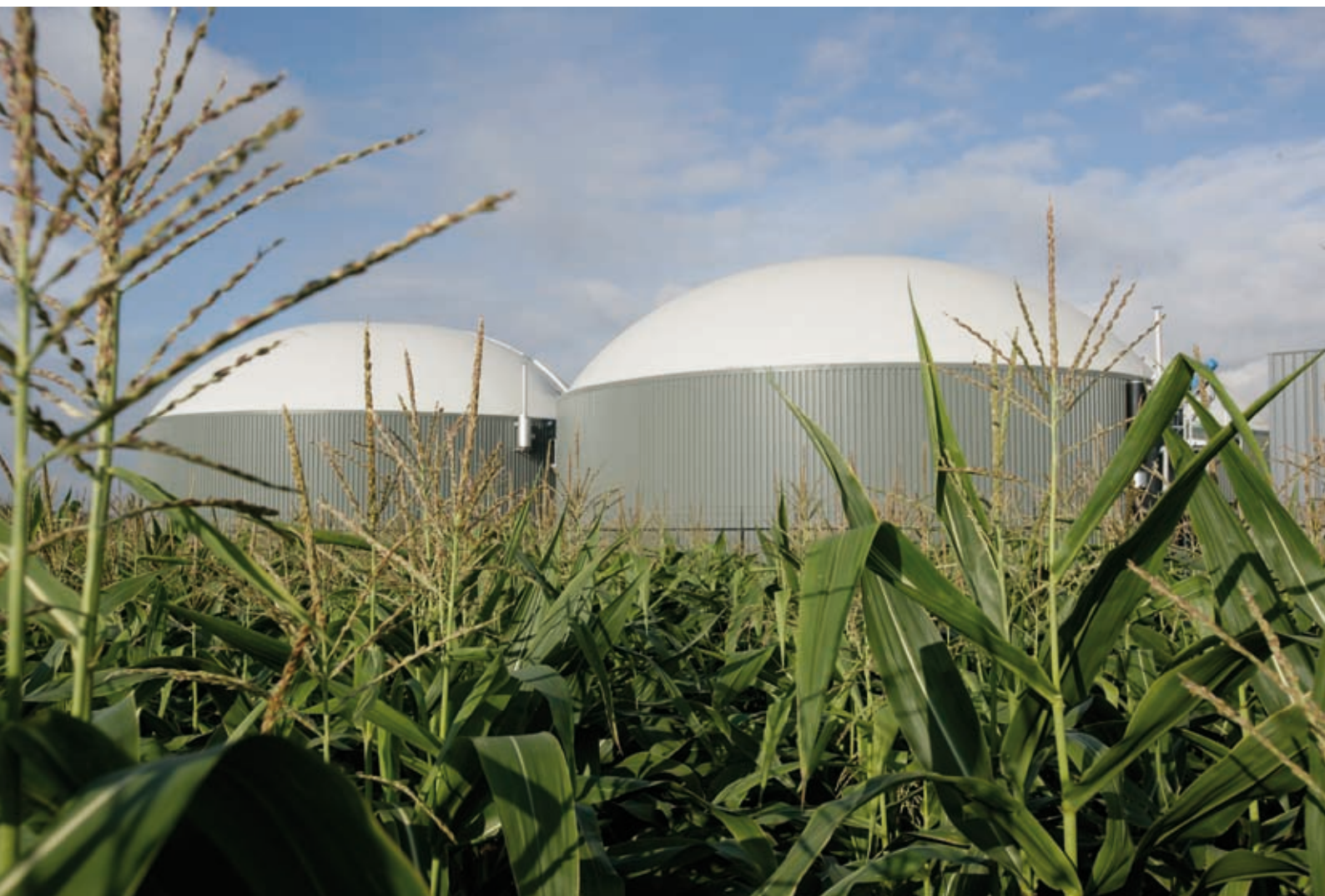
Biogasreactoren bij de biogasinstallatie te Wanroij.
