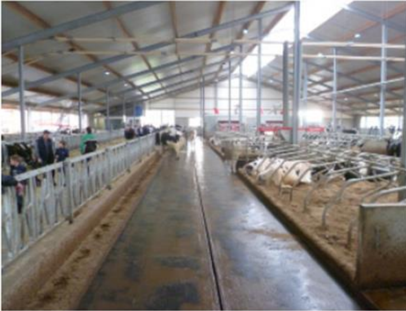
Herakles (gietasfalt op afschot met giergoot)
