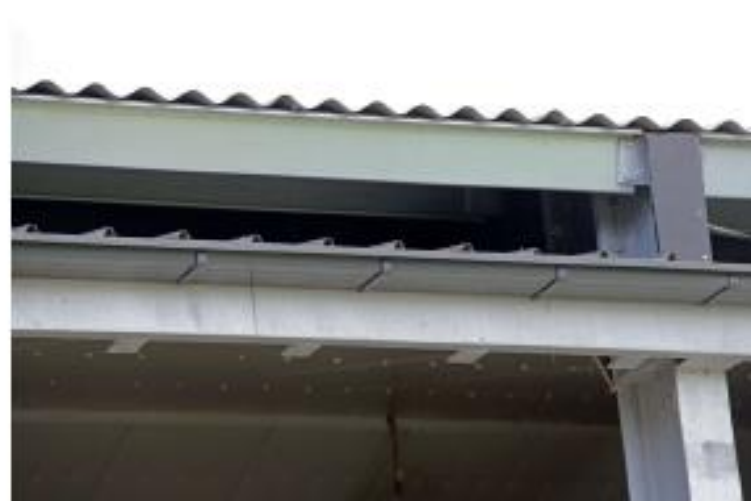
De hooischuur is uitgevoerd met dubbele wanden en een dubbel dak om de ventilatielucht aan te zuigen en op te warmen door zonnewarmte.
