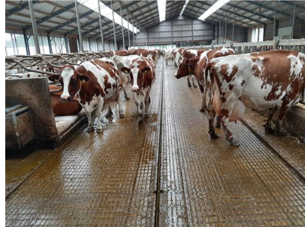
Betonnen scheidingsvloer, van Boxtel
