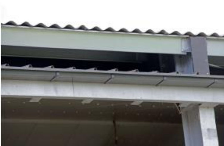
De hooischuur is uitgevoerd met dubbele wanden en een dubbel dak om de ventilatieklucht aan te zuigen en op te warmen door zonnewarmte.
